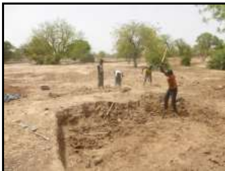
Travaux de surcreusage et de consolidation de la digue de Nabdgo
