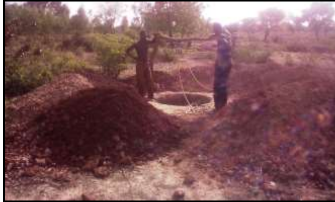
Bologo, travaux en cours sur le futur périmètre maraîcher
