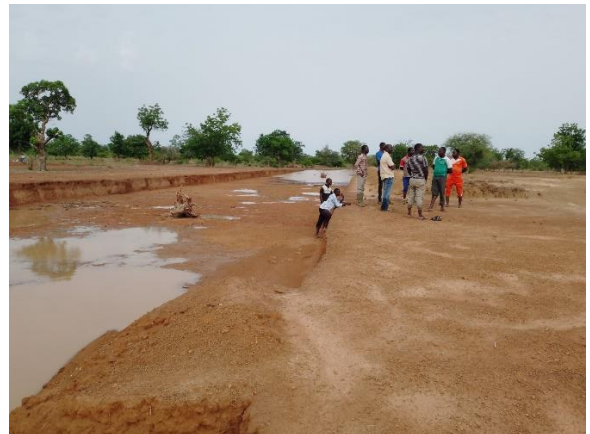
Le déversoir qui devra être agrandi
