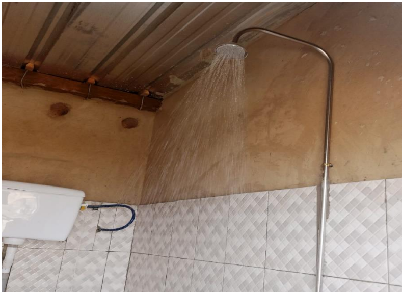
✚ Raccordements adduction d'eau : - Latrines : fait
