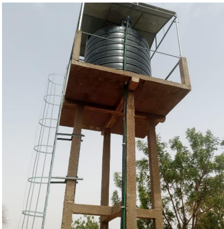
✚ Mini château de 10 000 L : installé et fonctionnel
