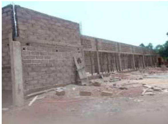
Amorce du gros œuvre réalisé pendant les vacances de Pâques pour le second bâtiment de l'école primaire
